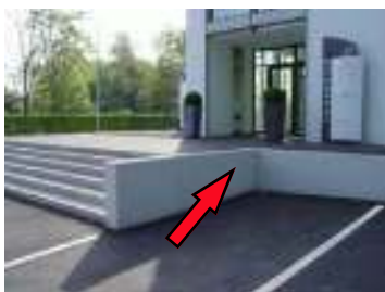
Schlüsselrohr Liegenschaft „Hammertor“, Sinslerstrasse
